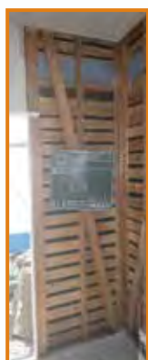
①既存壁の撤去
