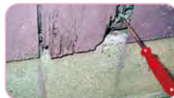
土台の腐朽度合いを調査
