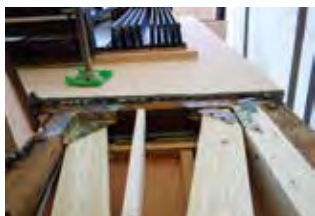
通し柱補強（室外より）
