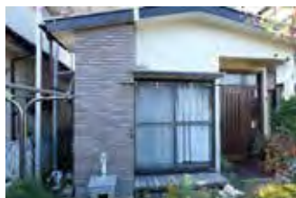
フレーム完成
