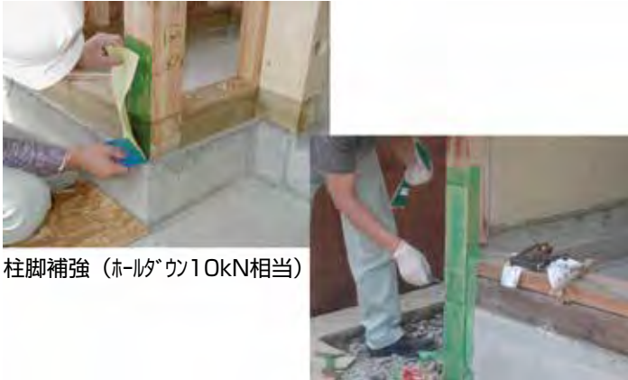
柱脚補強（ホルダウン15kN相当）
