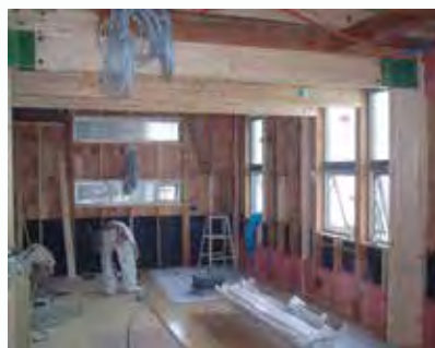
間仕切部の耐震補強
