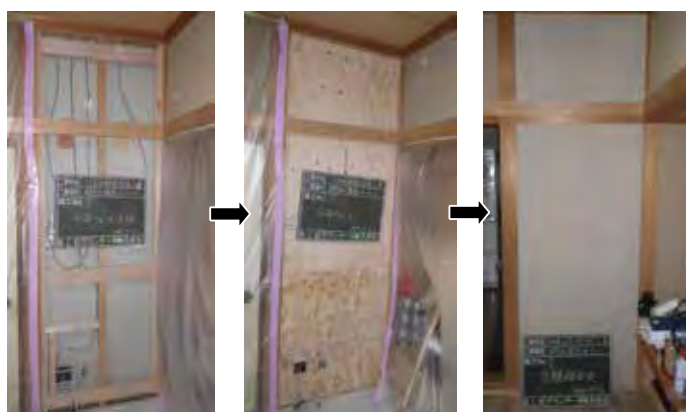
合板受材施工
