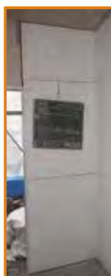
③パネルの施工
