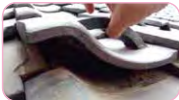
屋根瓦の葺き土の有無を調査
