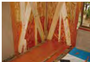
押入れ内補強
