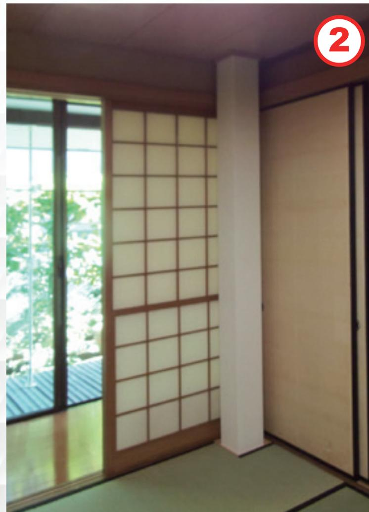
鉄骨の柱は壁紙で仕上げます。
