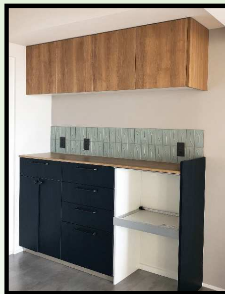
【デザインタイル】 キッチン収納のカウンター上は、 2列にデザインタイル貼
