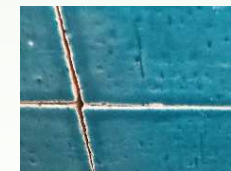
【ミラー背面壁】 ターコイズのエイジングタイルは、目地を 詰めずに施工して風合いを大切に
