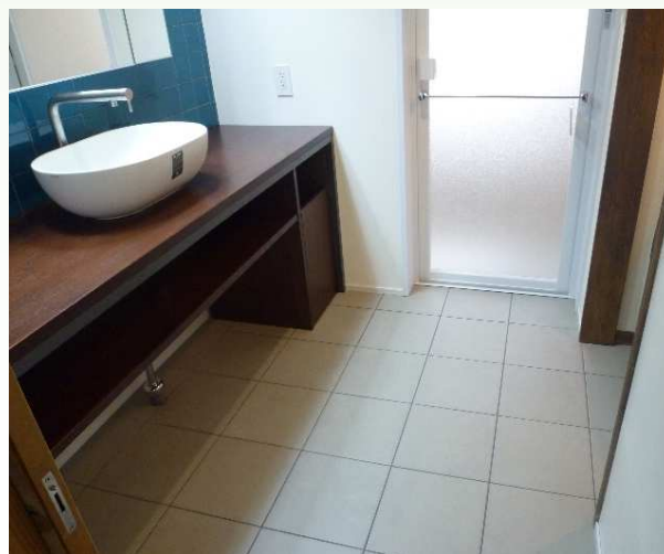
【床】 磁器質タイル、 冬場対策に床暖房を施工
