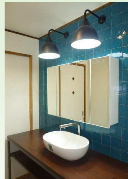
【ミラー背面壁】 ターコイズのエイジングタイルは、目地を 詰めずに施工して風合いを大切に
